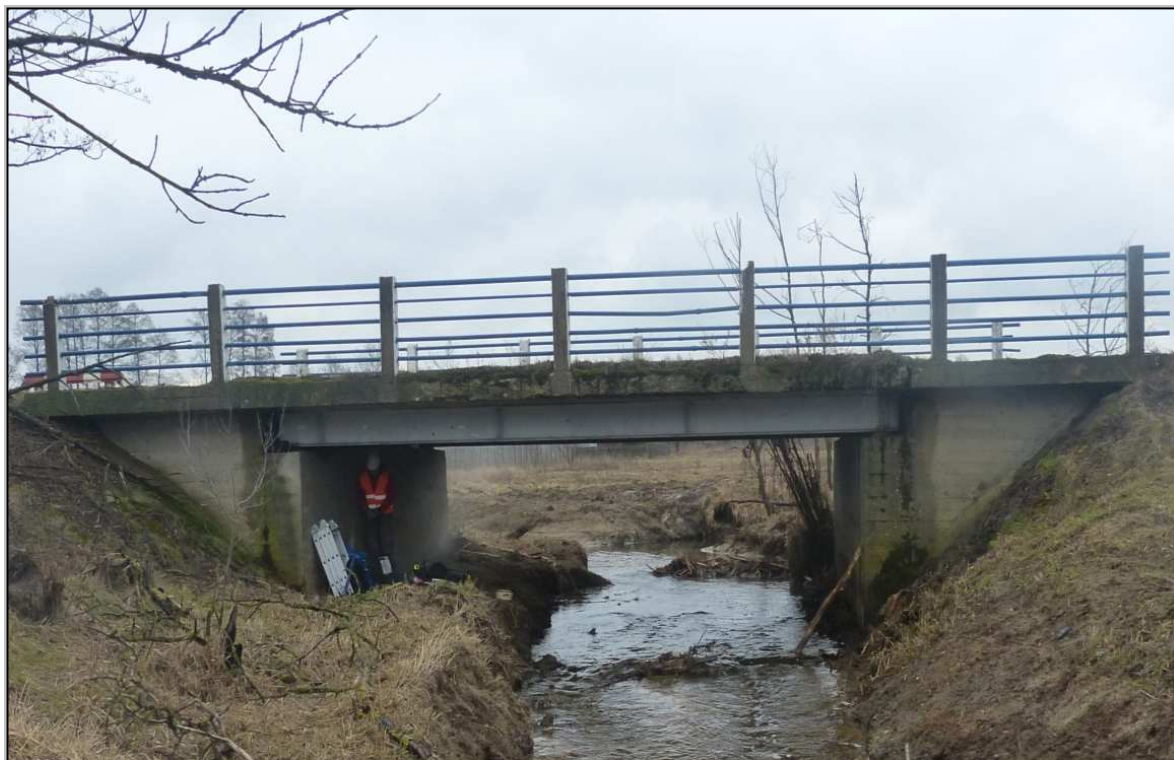
Rys. 2.1 Widok na obiekt od strony wody dolnej
