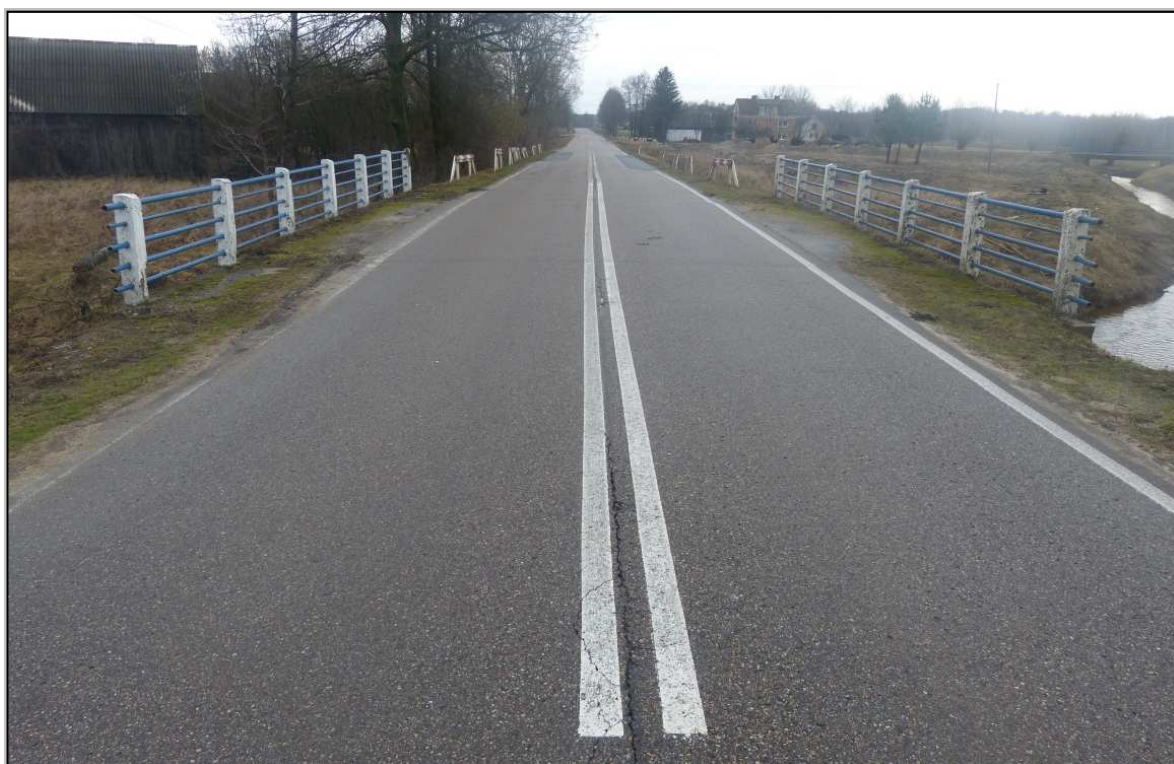
Rys. 2.2 Widok na obiekt od strony Miase
